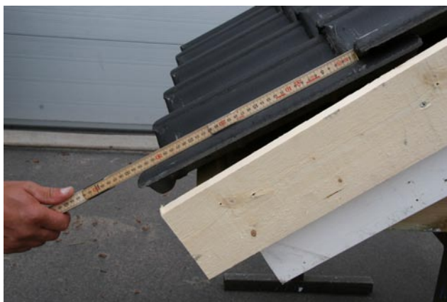
Monteringsbild 1. Börja med att kapa nedersta gavelbeslaget i rätt längd. Mät avståndet från nedre kanten på första takpannan till nedre kanten på takpannan i andra raden och lägg till ca 10 mm.
