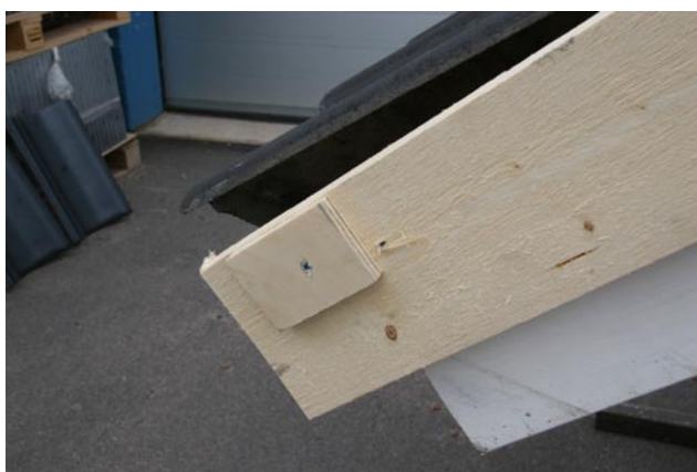
Monteringsbild 3. Lägg en distanskloss motsvarande gavelbeslagets betongjocklek vid nedre skruvhålet på första gavelbeslaget för att det ska få samma riktning mot vindskivebrädan som de överlappande gavelbeslagen.
