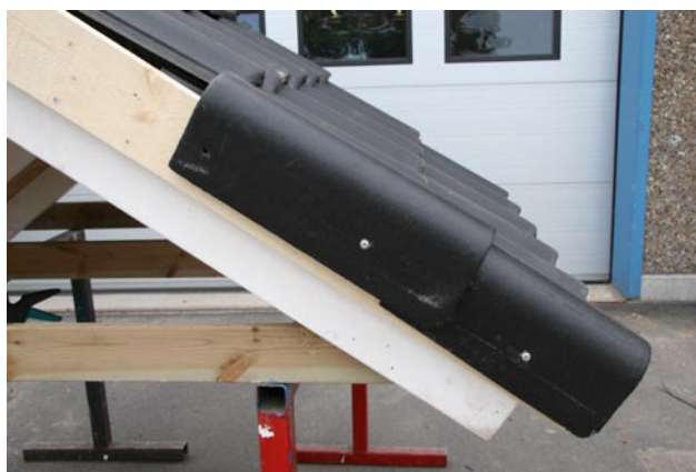
Monteringsbild 5. Borra i anvisningen och skruva fast gavelbeslaget i vindskivebrädan med rostfri skruv. Lägg överkanten på nästa gavelbeslag dikt mot nedre kanten på takpannan i rad nummer tre så blir gavelbeslagens täckande längd samma som takpannans läktavstånd. Fortsätt så upp tillnocken.
