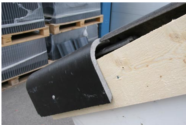
Monteringsbild 2. Kapa sen gavelbeslaget i överkanten efter detta mått. Då döljs kapsnittet av nästa gavelbeslag.
