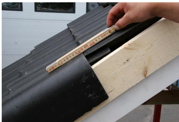
Monteringsbild 4. Lyft gavelbeslaget i överkant så att det får samma nivå som takpannan det möter. Detta medför att man undviker horisontella öppningar vid överlappningarna.
